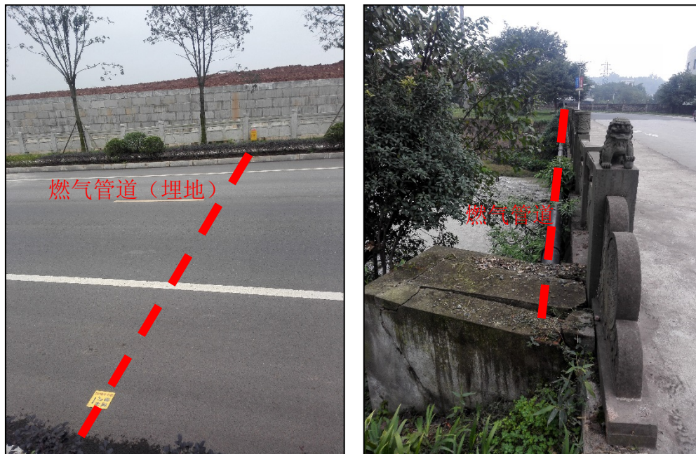
图 1-2 管道穿越园区道路、河流现状照片
