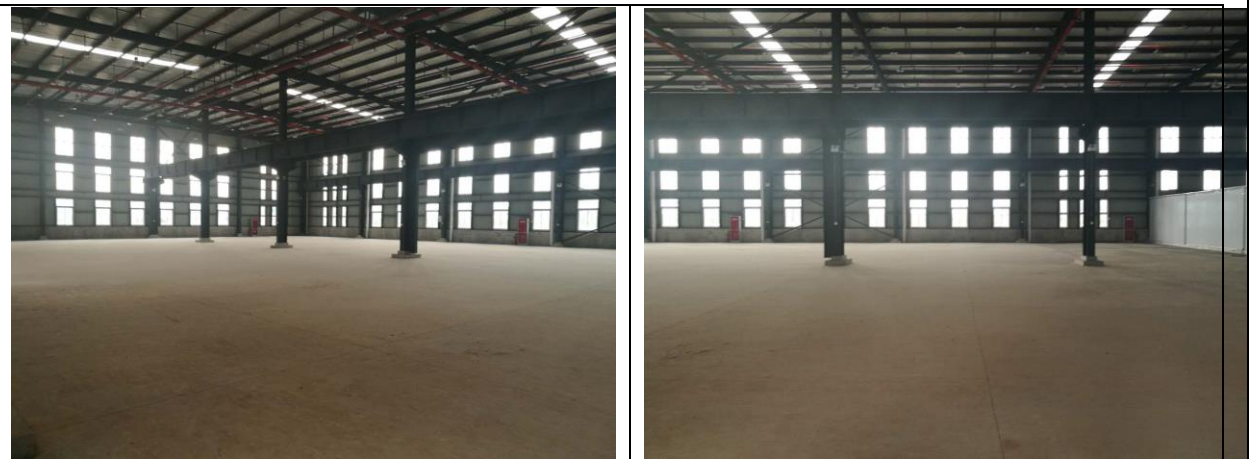
图 1-2 厂房车间现状图
