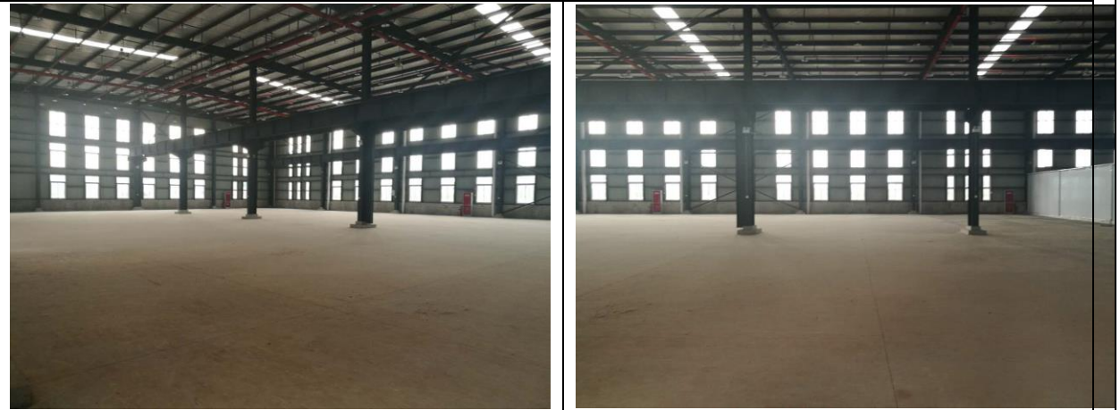
图 1-2 厂房车间现状图
