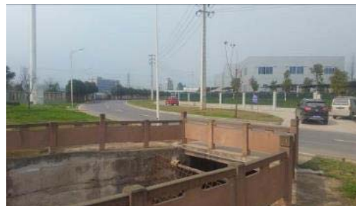
项目沟渠终点
