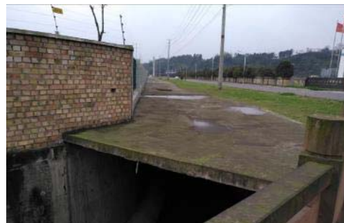
沟渠后段加盖板
