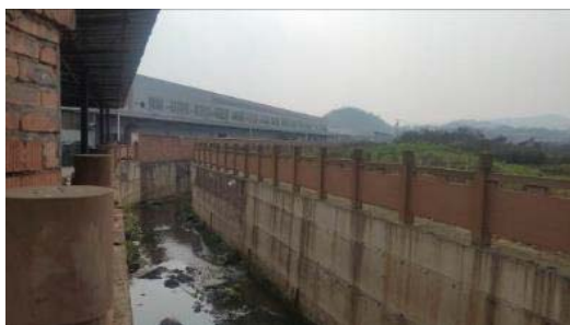
项目沟渠起点
