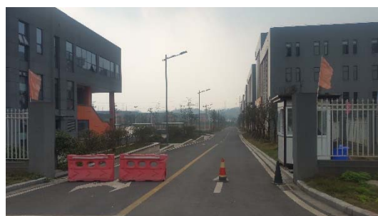
厂区大门及进厂道路
