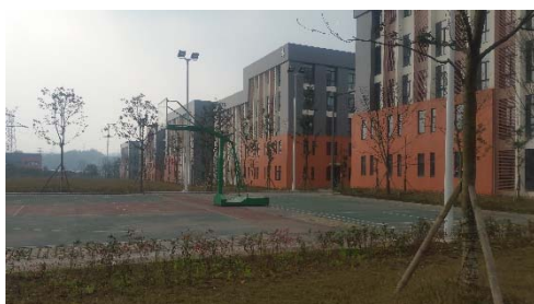
厂区配套设施
