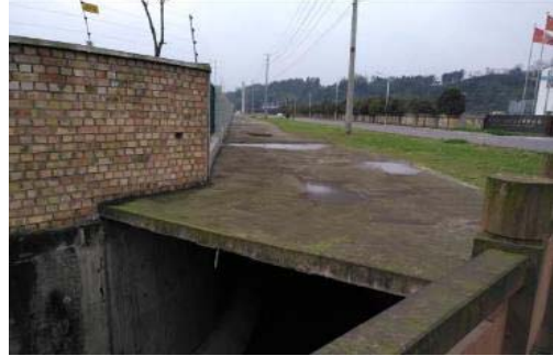
沟渠后段加盖板
