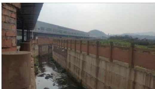
项目沟渠起点
