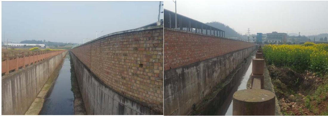
河道沟渠整治及改道工程建成后情况
